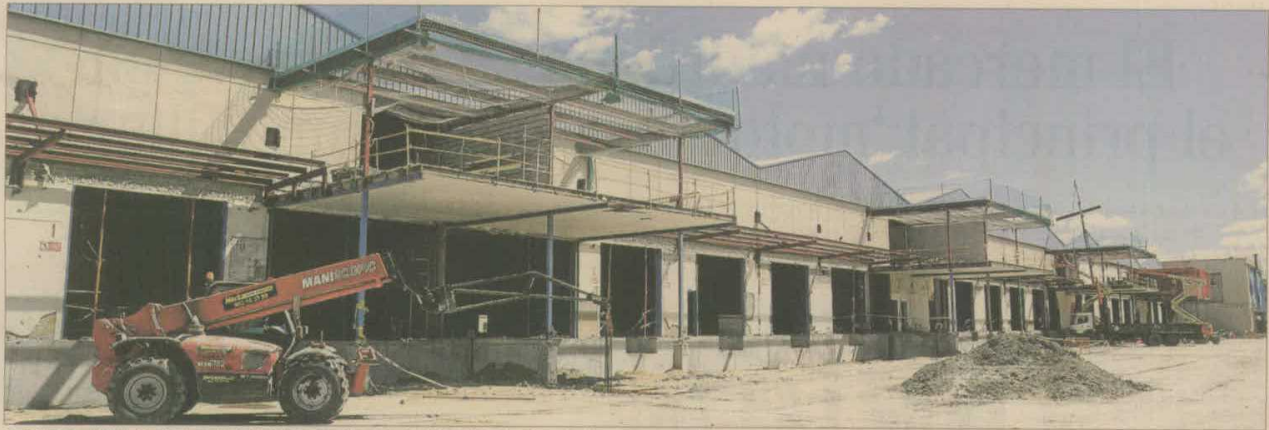
Trabajos de construcción de una nave industrial en el polígono de Las Mercedes, situado en Madrid. / SERGIO GONZÁLEZ
