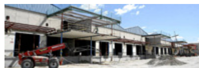
Trabajos de construcción de una nave industrial en el polígono de Las Mercedes, situado en Madrid. (Foto: Sergio González)
